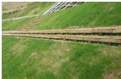
（治山工事への県産材利用の様子）
