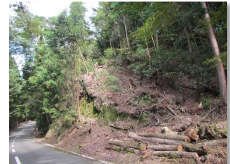
(伐倒・棚積み処理の様子)
