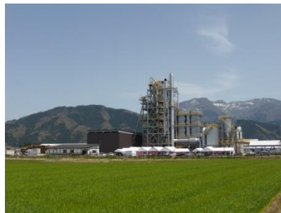
（木質バイオマス発電所）
