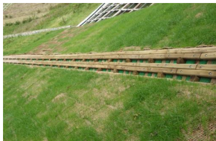
（治山工事への県産材利用の様子）
