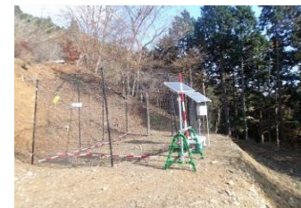
【マンガ谷国有林囲い罠設置の様子】
