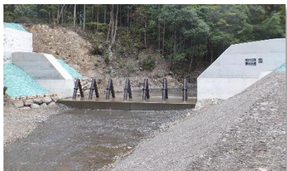
（H28施工したスリットダム）
