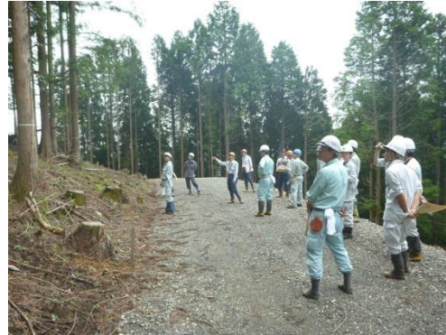
(連絡調整会議出席者への作業道取り付け箇所の説明)
