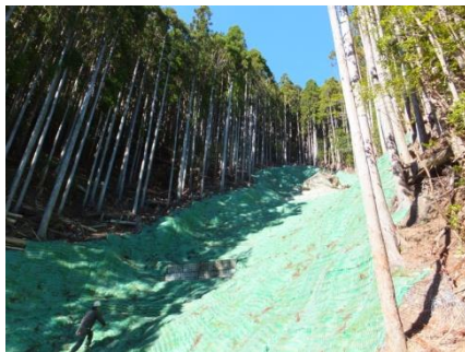
（国有林で施工した山腹工事）
