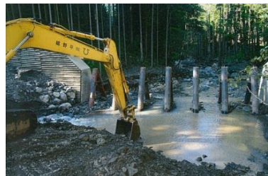
（既設スリットダムに堆積した流木等の除去の様子）
