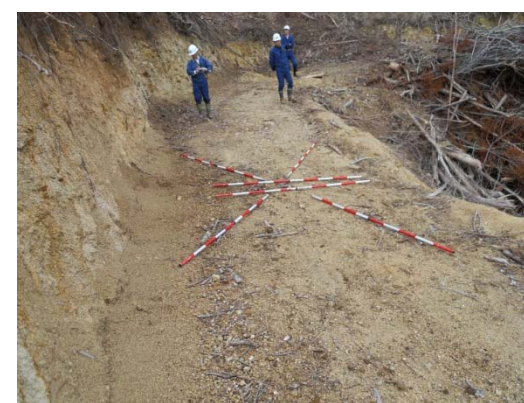
既設森林作業道の排水状況を確認
