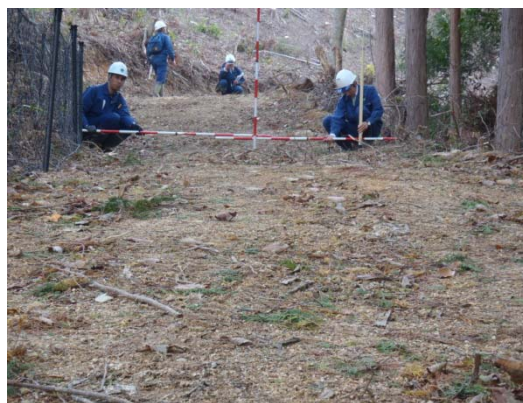
既設森林作業道の横断勾配を確認
