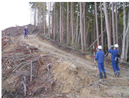
既設森林作業道の縦断勾配を確認
