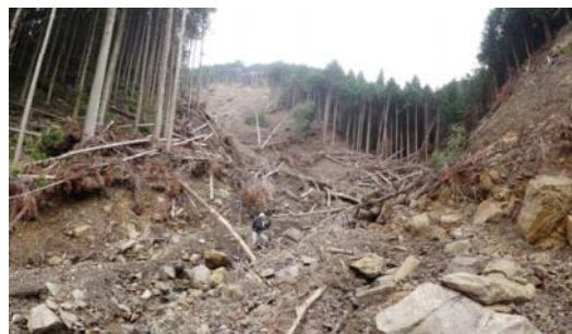
【大規模な山腹崩壊の様子】 (和歌山県田辺市 紀伊田辺地区民有林直轄治山事業)
