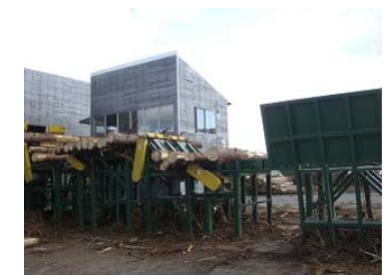
【システム販売先合板工場の様子】
