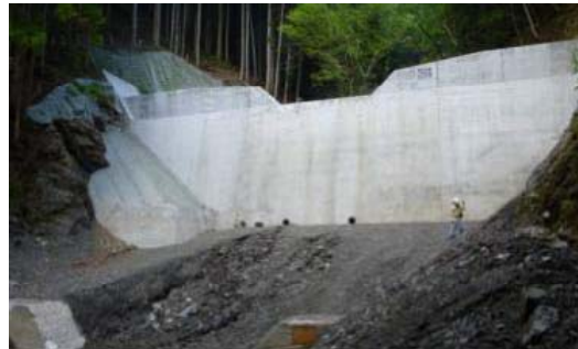
【災害復旧事業により完成した溪間工】 (奈良県十津川村 十津川地区民有林直轄治山事業)
