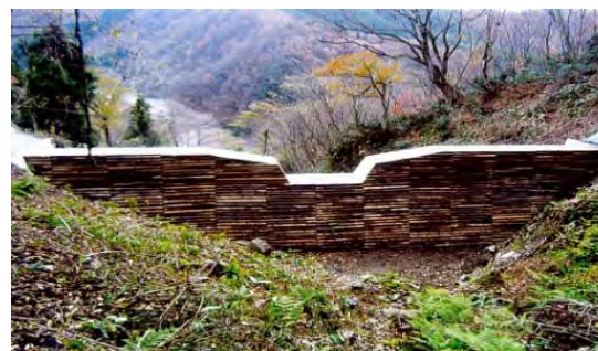
間伐材を使用した型枠
