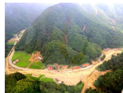
島根県津和野市(民有林)の被災状況
