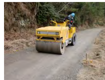
鉄鋼スラグ路盤工（転圧作業）の様子
