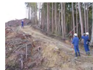
既設森林作業道の縦断勾配を確認
