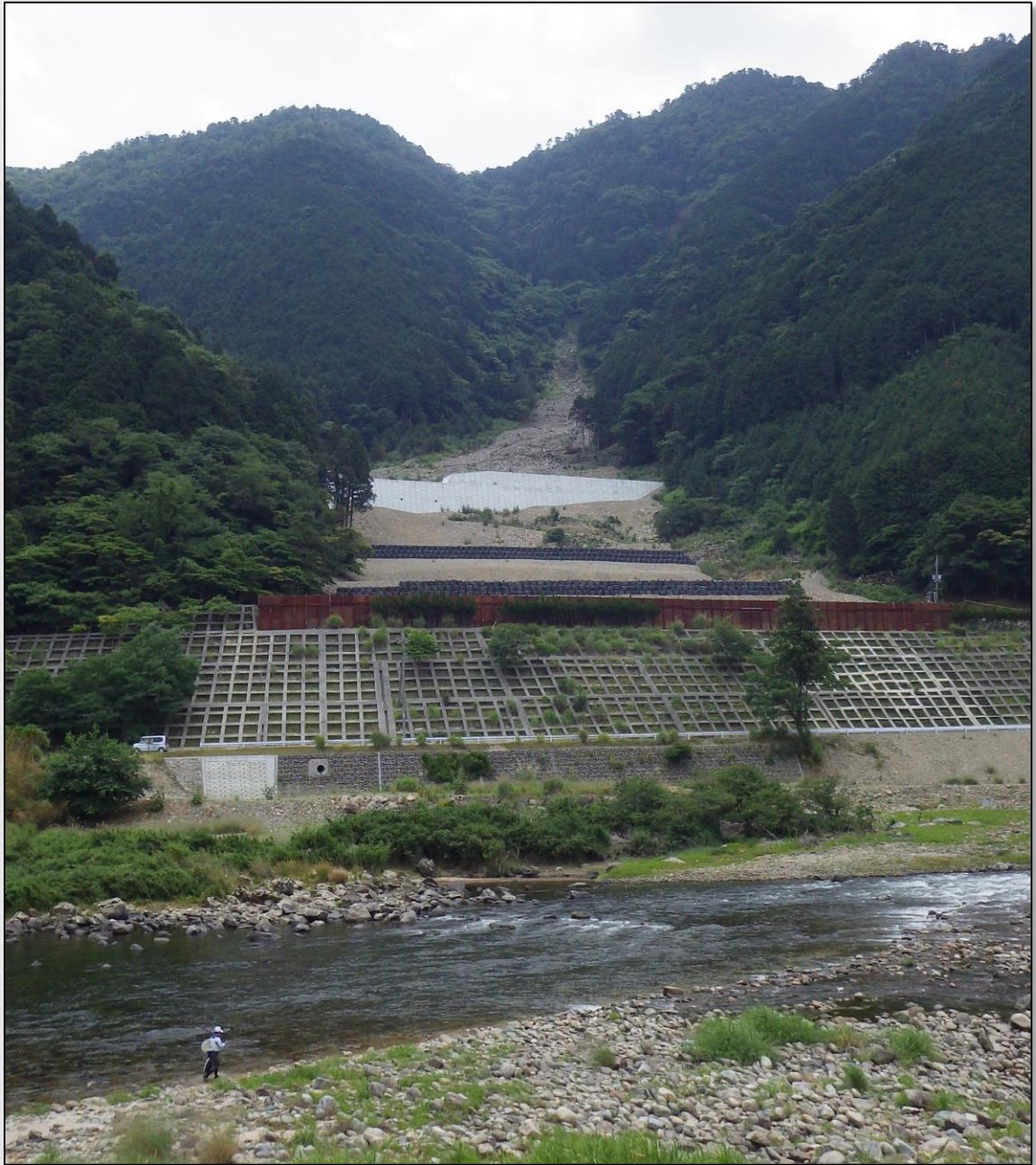
犬戻鳴山国有林「ソイルセメント谷止工」
