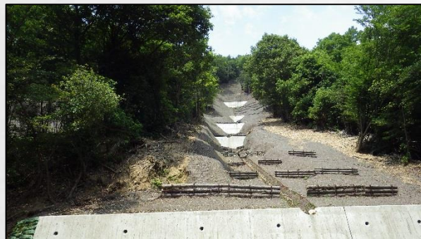
高松山国有林「コンクリート土留工」
