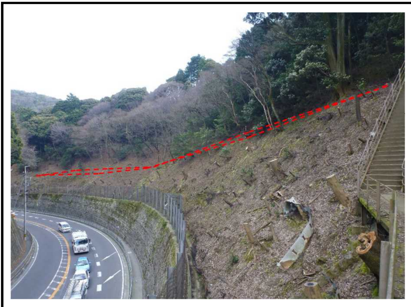
【国道1号線沿い・伐採②】
