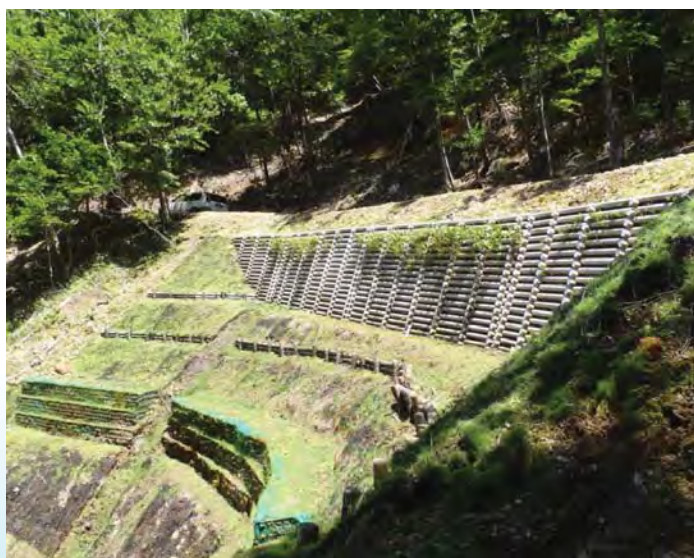
山腹工施工後（白谷山国有林：十津川村）
