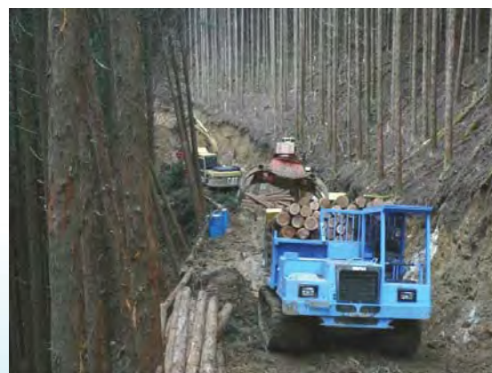
森林共同施業団地内での木材搬出作業 (西ノ河国有林：日高川町)
