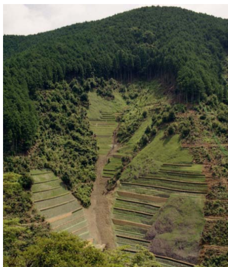
山腹工施工地(野々川国有林)
