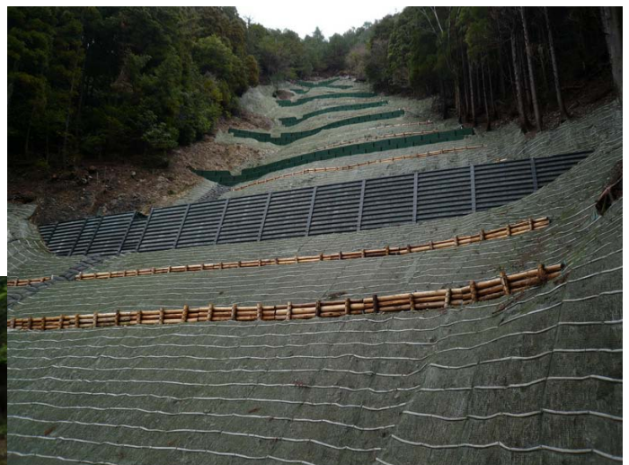
山腹工施工地 野々川国有林 (和歌山県日高川町)
