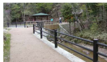
歩道整備状況
