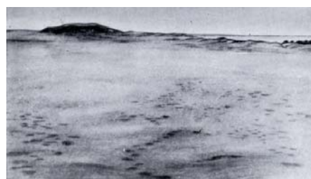
復旧前の状況
