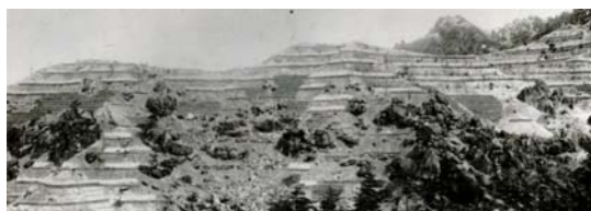
山腹工施工状況
