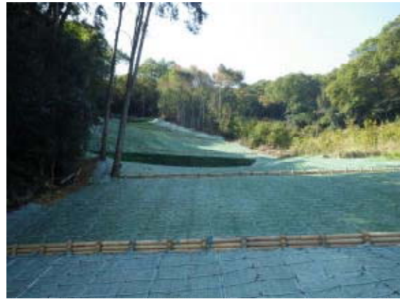
○木材を利用した治山工事 清水坂山腹工事（加古川市清水坂国有林） 丸太筋工（5m 利用）
