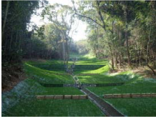
加古川市清水坂国有林山腹工事
