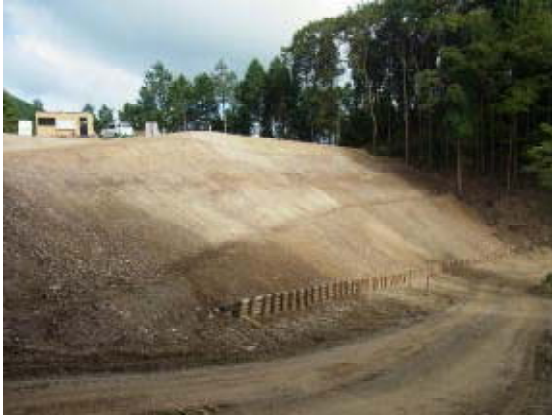
○木材を利用した治山工事 清水坂山腹工事（加古川市清水坂国有林） 丸太筋工（5m 利用）
