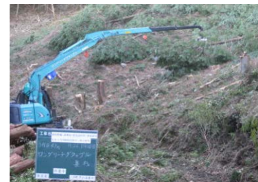
ロングリーチグラップルによる全木集材及び地拵え
