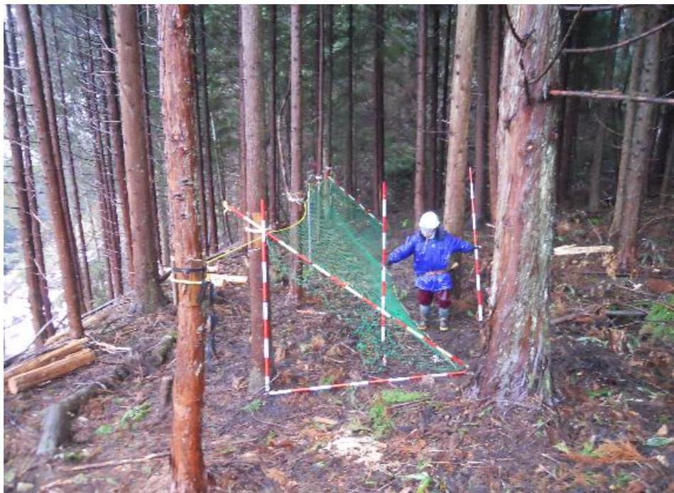
斜め張り(参考:埼玉県資料)を参考に、上側:雪対策として、支柱に控え索を付けることにより、ネットの転倒防止。下側:立木を支柱として利用し、コスト削減。
