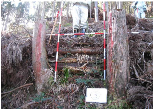
中段切り生杭と丸太土留め
