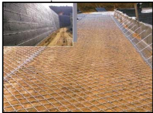
(参考)エキスパンドメタルの施工例
