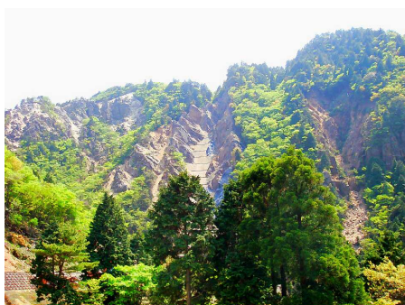
崩壊地の山腹工事箇所（黒滝国有林）
