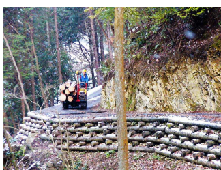
低コスト路網による間伐材搬出（別所国有林）
