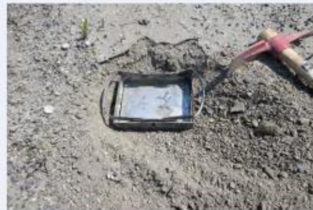
④踏み板を置いて深さをチェック
