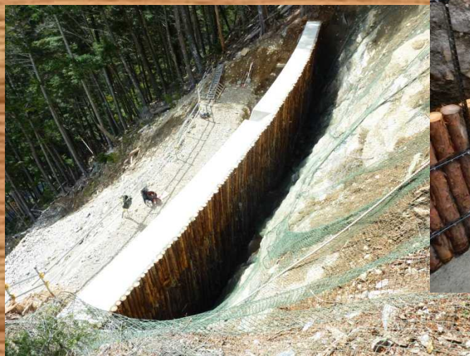
丸太残存式型枠を使用したコンクリート土留工及び谷止工の施工例
