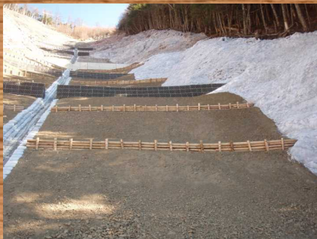
山腹工における木柵の施工例
