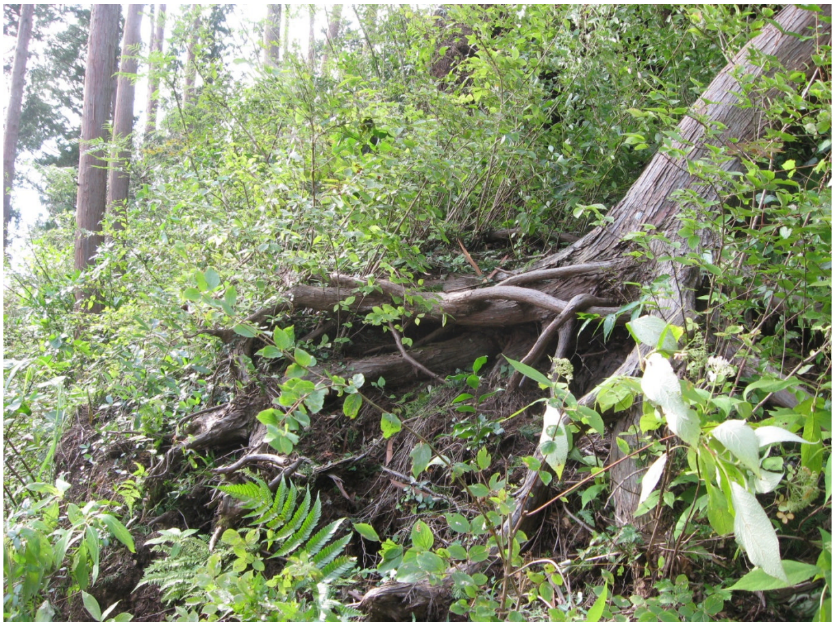
根が浮いた状況
