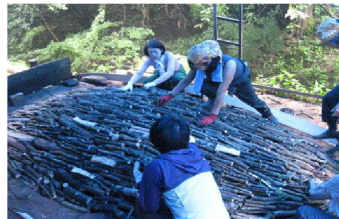
7月12日(第4回):天井部敷木作業の様子
