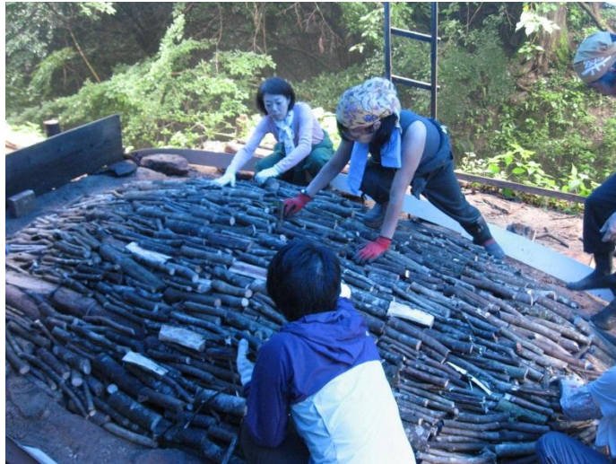
7月12日（第4回）：天井部敷木作業の様子
