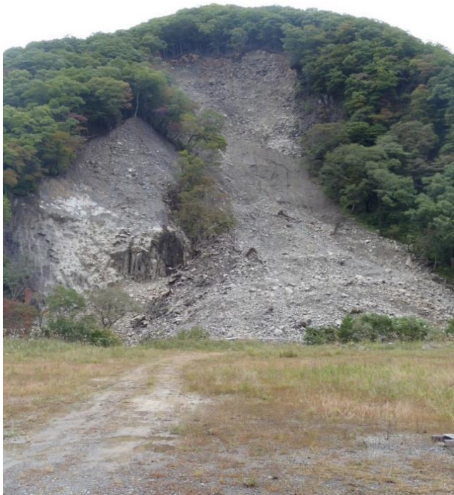
法面崩落災害(戸倉山) (H23年7月)
