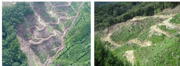
▲ 伐採実施箇所 (左:ドローン撮影、右:地上より同地点を撮影)
