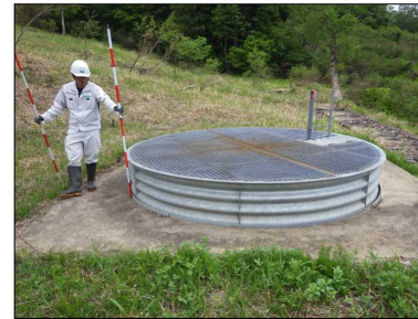
【集水井工完成状況】
