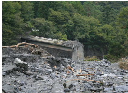
写真-1 大玉橋の損壊状況
