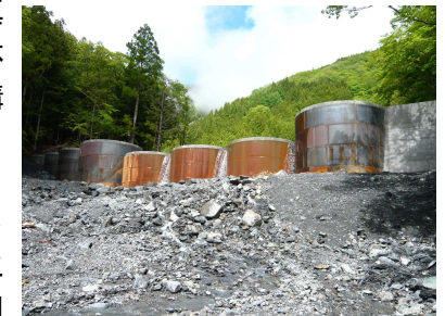
写真-3 セルダム
