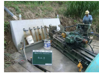
【横孔ボーリング施工状況】
