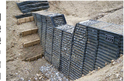
写真-2 鋼製自在枠ダム
