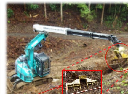
[ レキ を使用して地拵中のロングリーチラップル]
