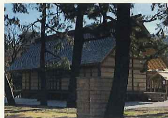
廻立殿の外壁に胴縁材として使用
