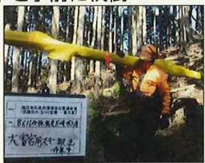
傷防止のため、保護材を巻き人肩運搬
