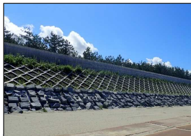
(写真-2) 防潮護岸
