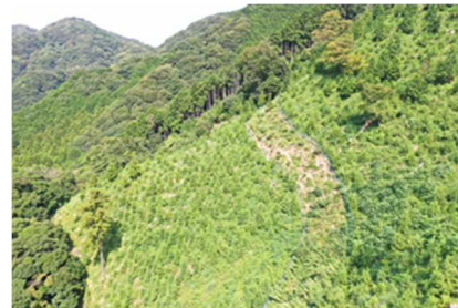
(ブロックディフェンスの設置状況)
