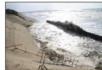
(写真-3) 施工箇所の波浪被害
