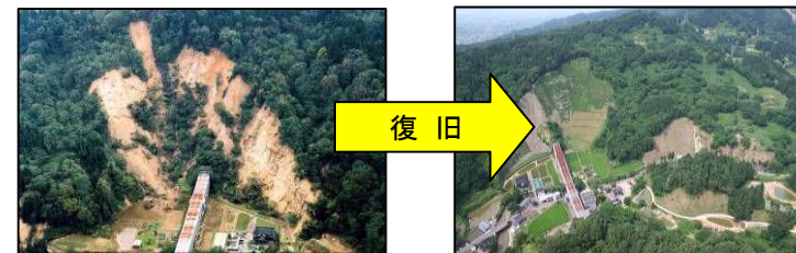
新幹線トンネル入口で発生した災害の復旧
