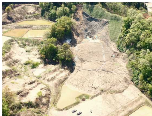
上山区域の被災状況（H31）
