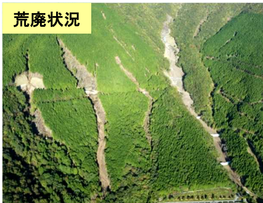
北郷区域 荒廃状況(角取山工区)
