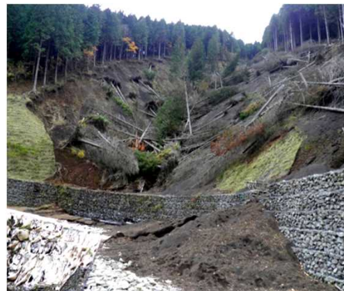
角取山工区 崩壊状況
