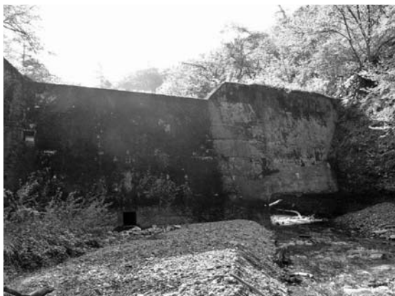
このダムの中央部分を取り壊す予定です
