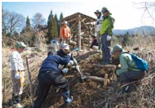
いきもの村でトレイル整備をするサポーター
