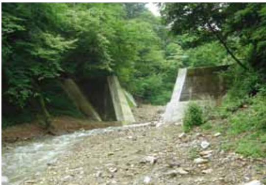
治山ダムの中央部を撤去
