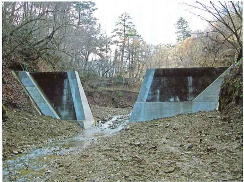
中央部を撤去した茂倉沢治山ダム
