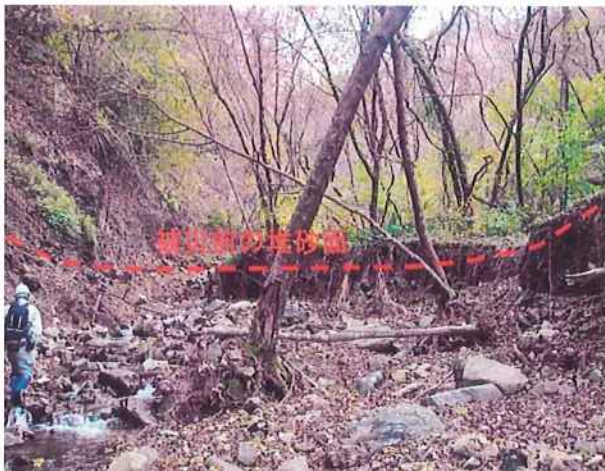
平成20年8月豪雨後の状況
