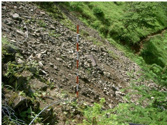
施工前(荒廃地)
