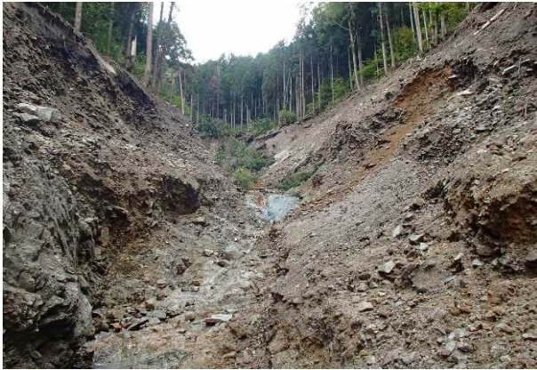
施工前（山腹荒廃状況）
