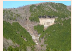
施工した山腹工
