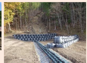
応急工事の土留工等
