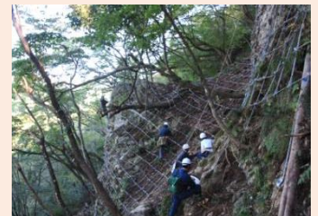
予防治山工事(落石防止工)
