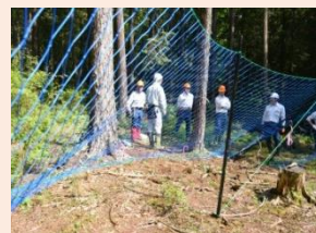
低コスト防護柵（斜め張りネット）※内側から撮影
