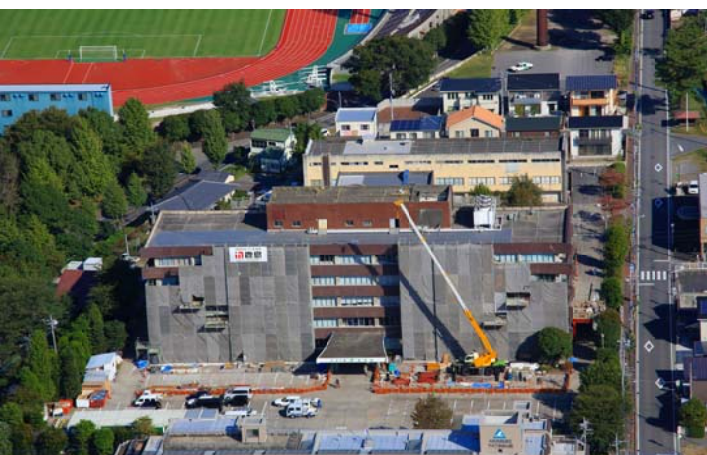
局庁舎耐震改修工事中
