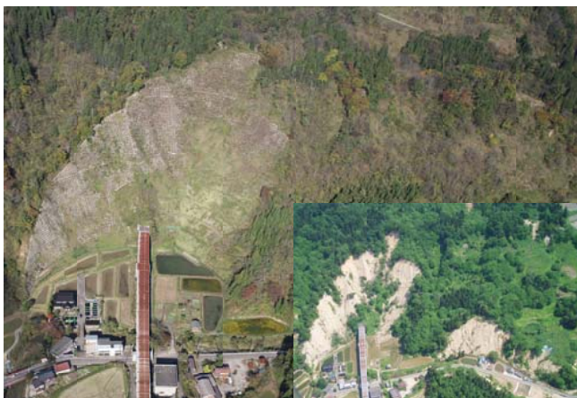
復旧が進む新潟県中越地震の施工地
