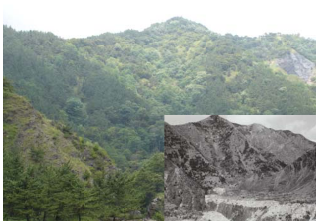
復旧が進む足尾の施工地
