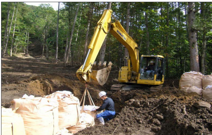
応急復旧措置:利根沼田森林管理署管内 (群馬県みなかみ町)
