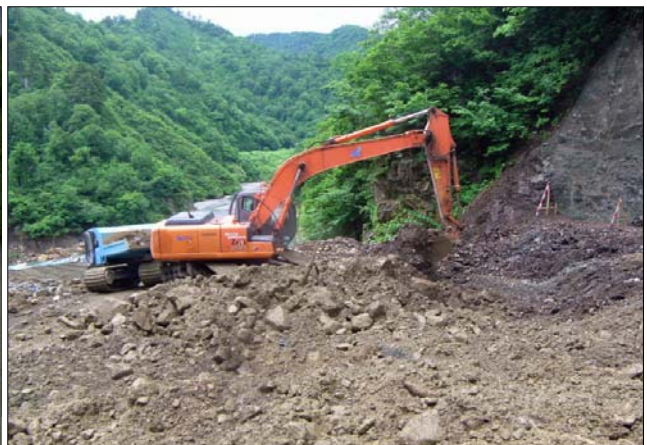
復旧治山工事:中越森林管理署管内 (新潟県魚沼市)
