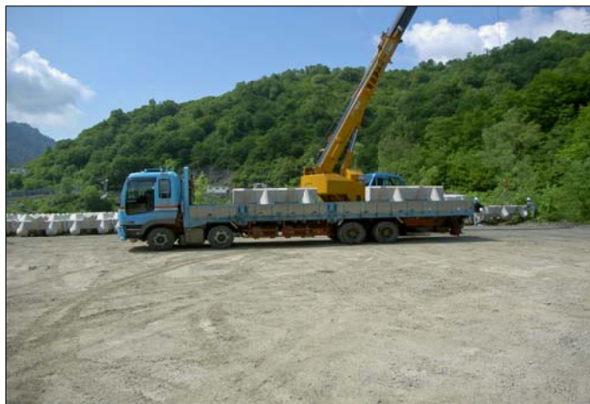
コンクリートブロック製造ヤード: 同右
