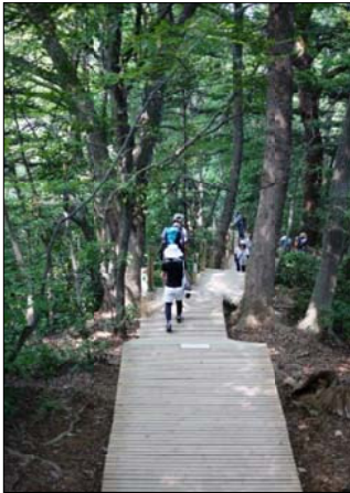
修繕をした「いろはの森」歩道
