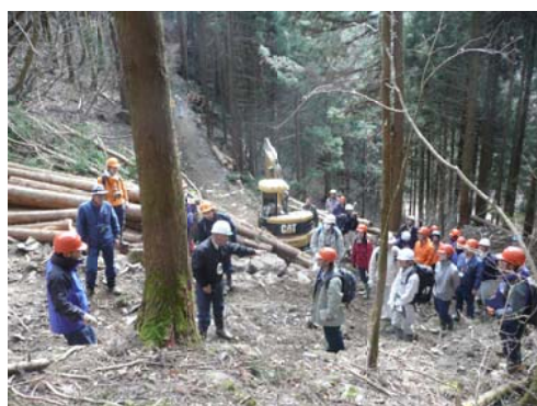
森林作業道作設の現地検討会
