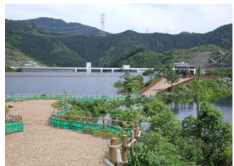
太田川ダムの最高水位試験状況
