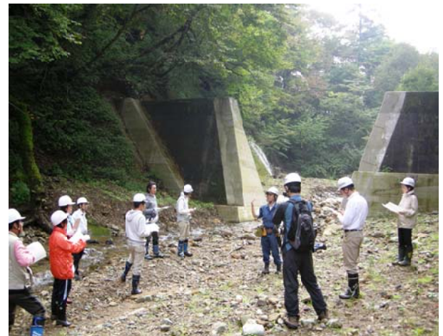
治山ダムの一部を取り除いた現場を見学
