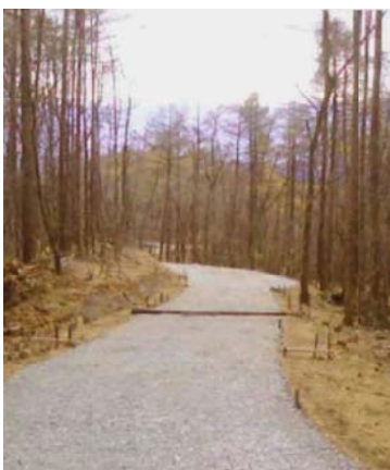
地形を考慮した継続的作業道
