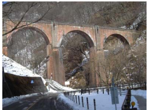
レンガ造りの碓氷第三橋梁(通称めがね橋)
