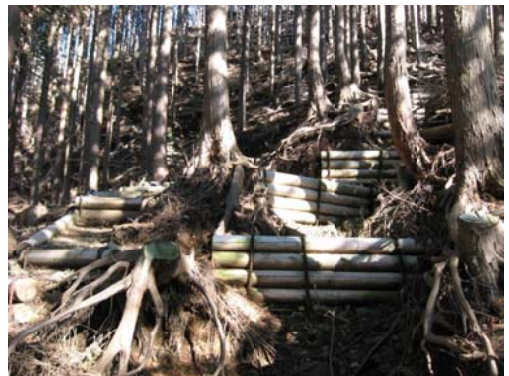
雨水による表面侵食を防ぐ簡易丸太筋工
