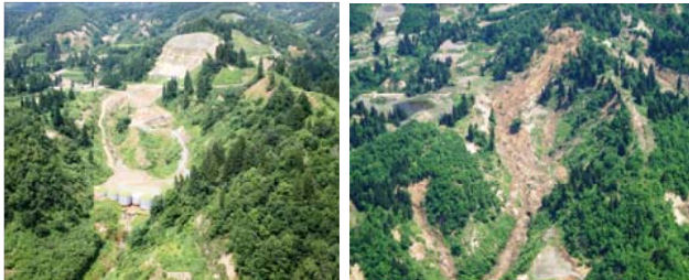
民有林直轄治山事業（新潟県長岡市 旧山古志村） 左：施工後 右：施工前
