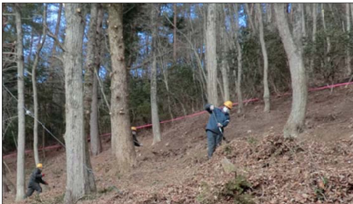
森林の除染(落葉等の堆積有機物の除去)
