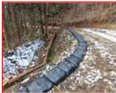
土のう工 林内から土砂が溪流に流入することを防止するため、作業道の路肩に土のうを設置
