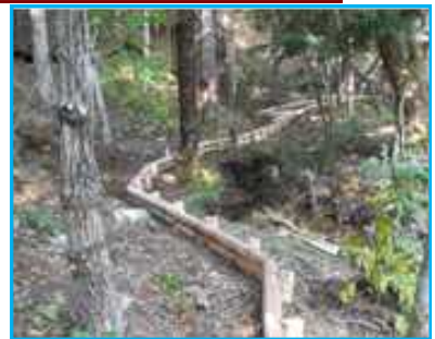
木柵工 間伐実施後の間伐列の谷側や取水施設周辺へ土砂が流出しないように木柵を設置
