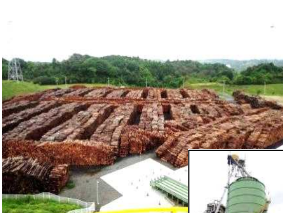
バイオマス発電施設と 燃料用原木
