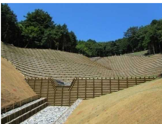
間伐材を利用した治山工事
