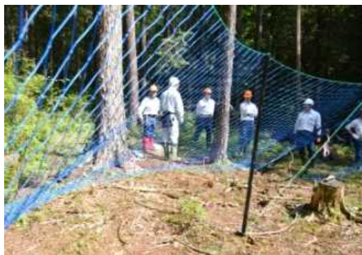
低コスト防護柵(斜め張りネット) ※内側から撮影
